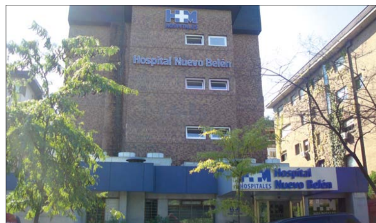
Fachada actual de HM Nuevo Belén.
