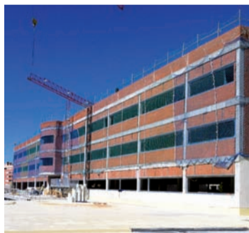
Estado de la fachada
