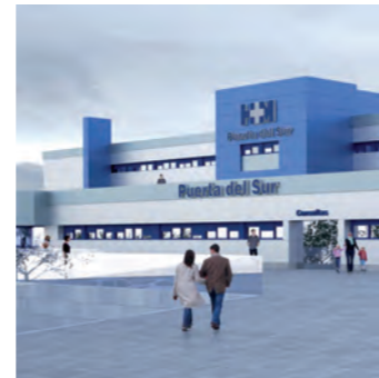
Hospital Universitario HM Puerta del Sur, Móstoles. Madrid.
